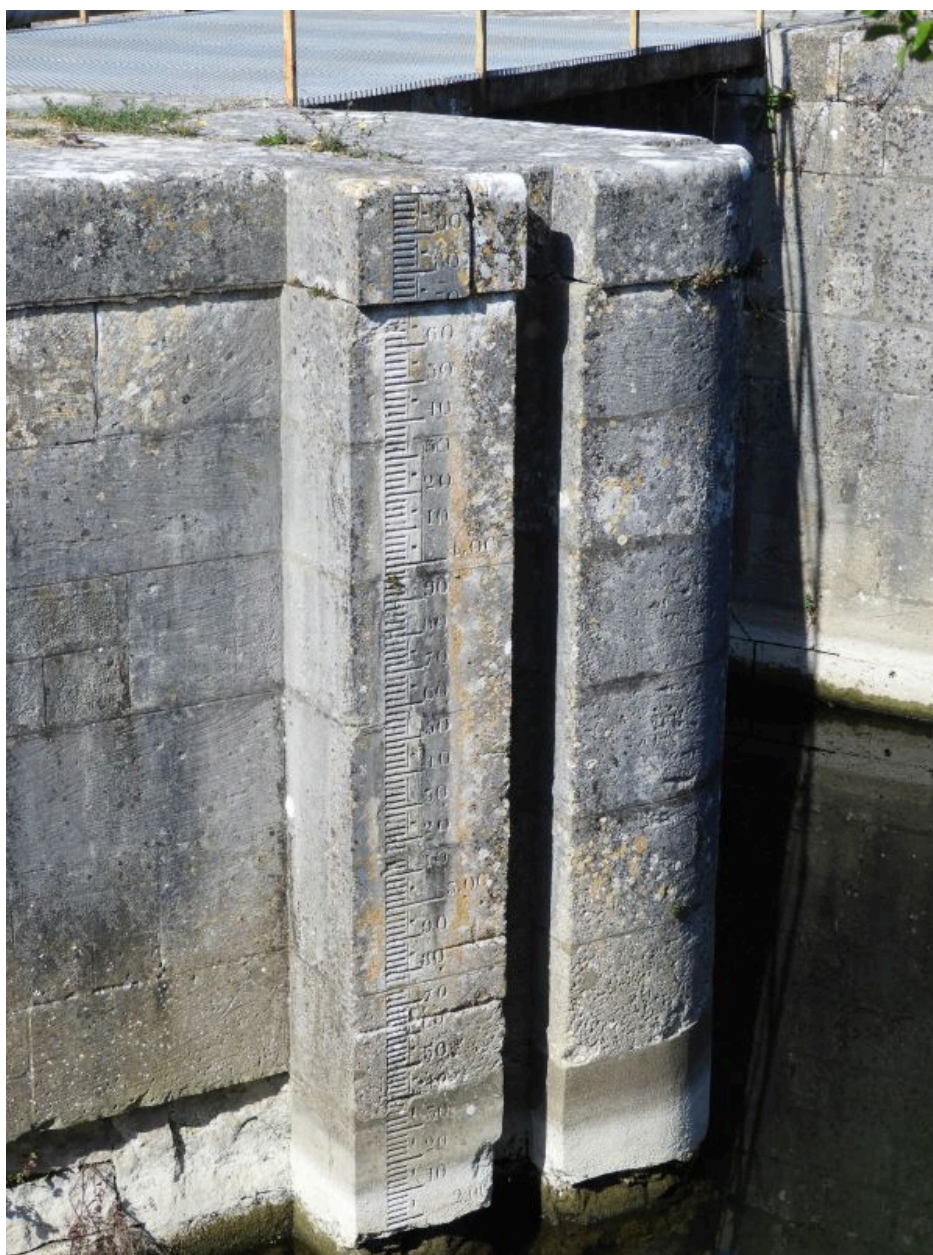
Echelle graduée pour mesurer le niveau d'eau, à la tête amont de l'écluse, rive droite.
