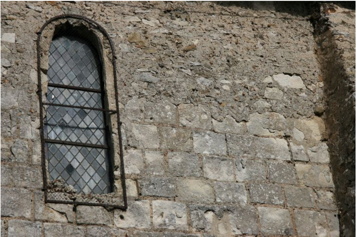
Mur sud de la nef, baie.
