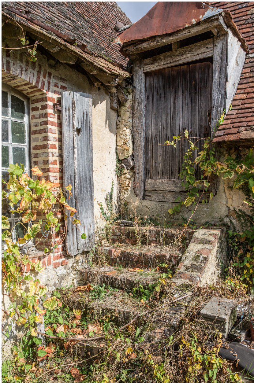
Le détail de l'escalier menant au grenier.
