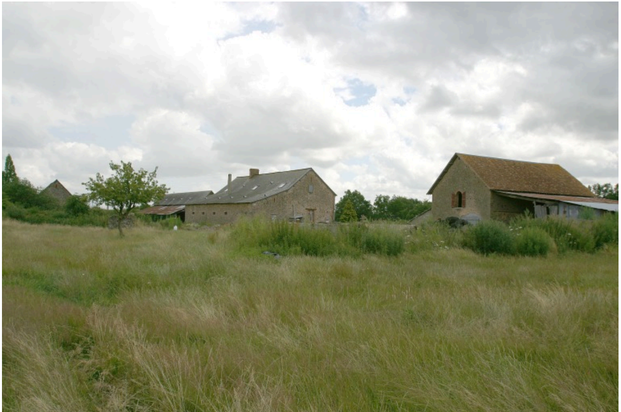
Vue d'ensemble depuis le nord-ouest : la remise, la porcherie, le logis, l'étable.
