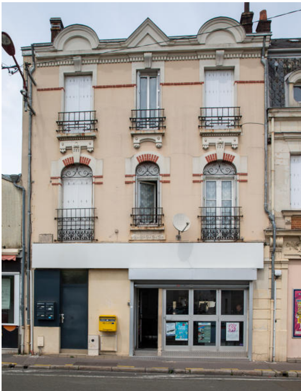
Vue d'un immeuble signée Levesque rue Gambetta.
