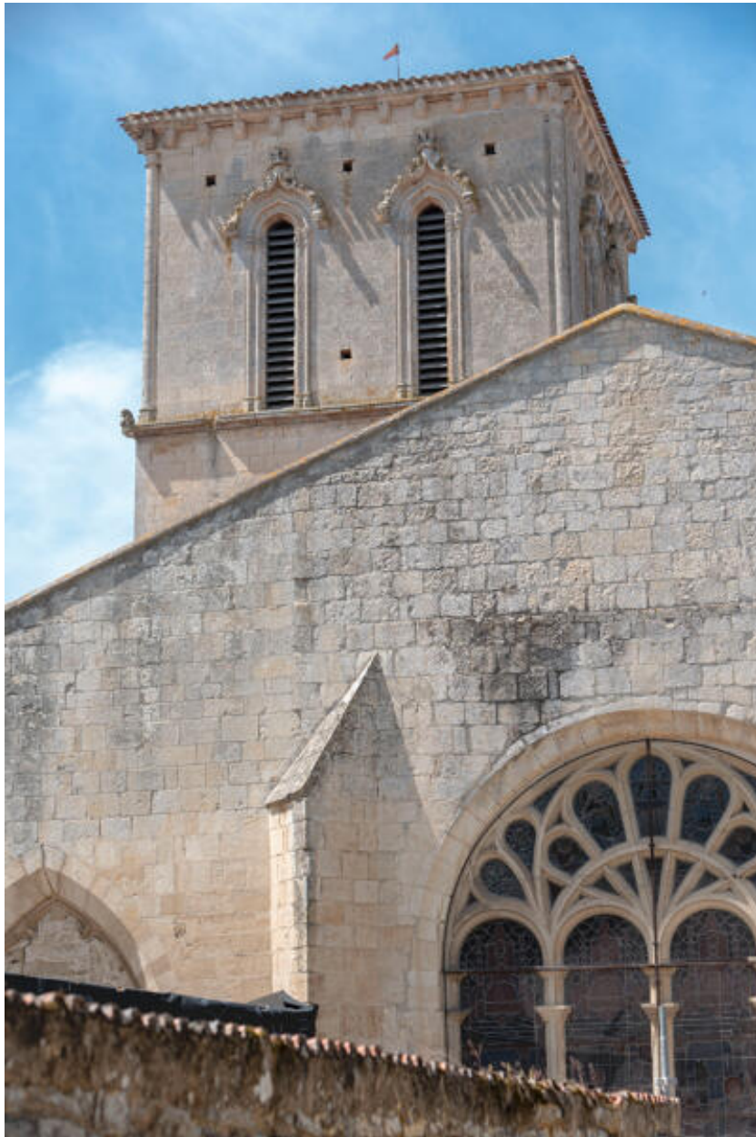
Le mur de chevet et le clocher vus depuis l'est.
