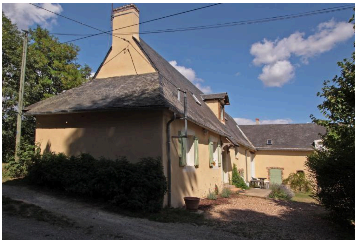
Vue de volume de la maison.
