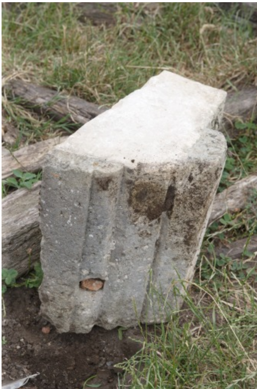
Elément de piédroit stocké devant la maison.
