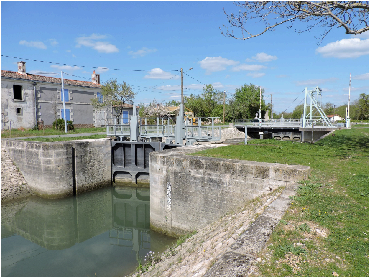
L'écluse vue depuis l'aval, au sud.
