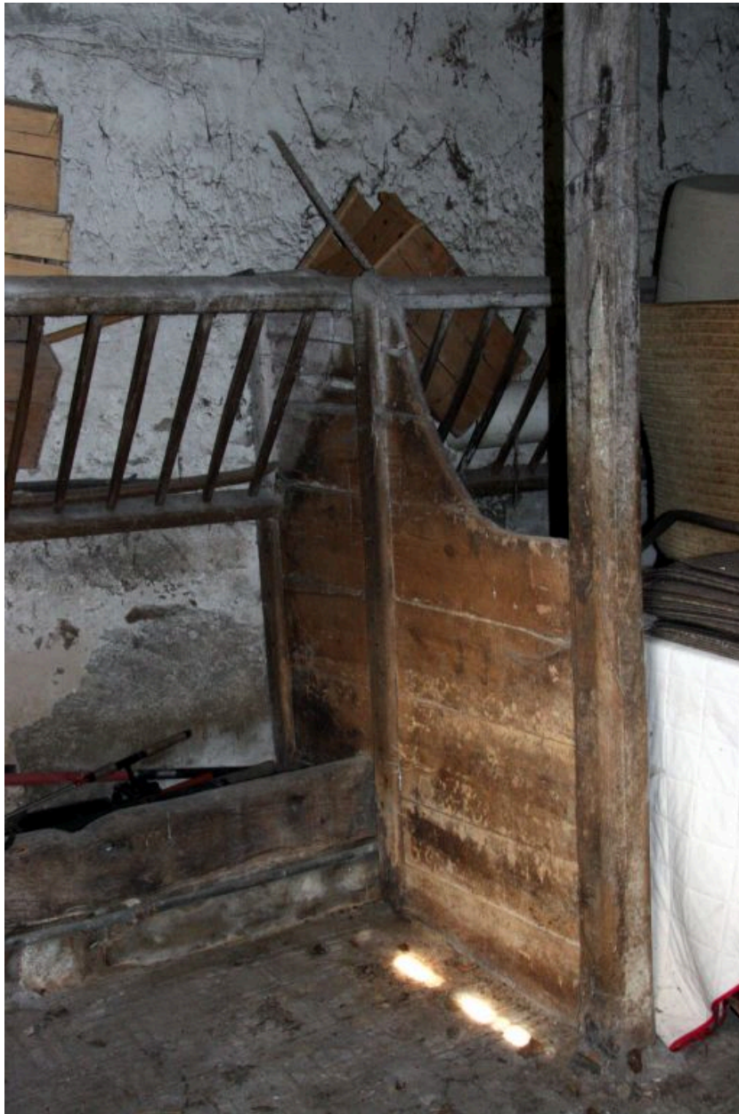
Les bas flancs et mangeoire des étables.
