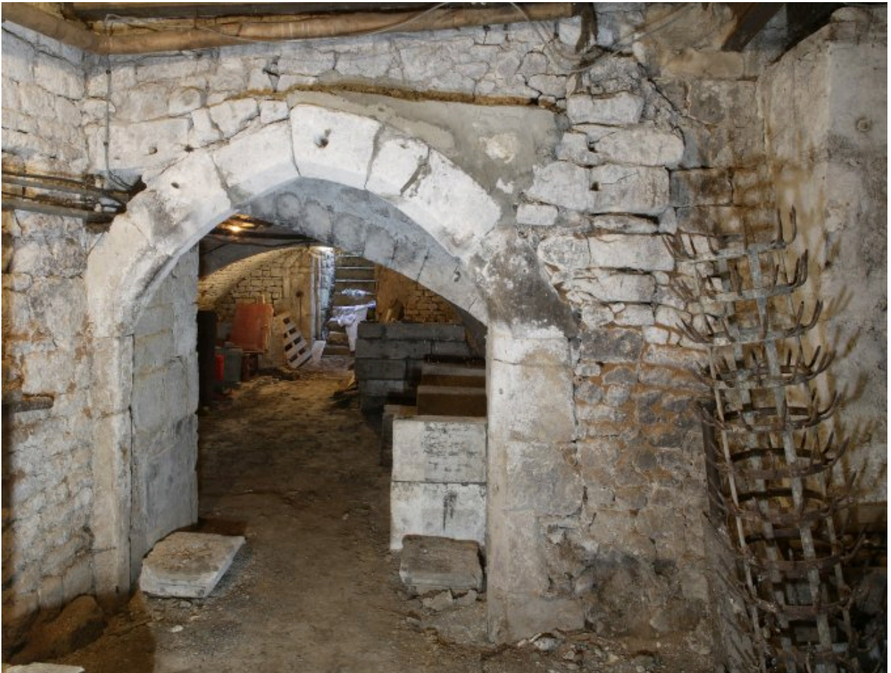
Vue du sous-sol situé sous la salle de café.
