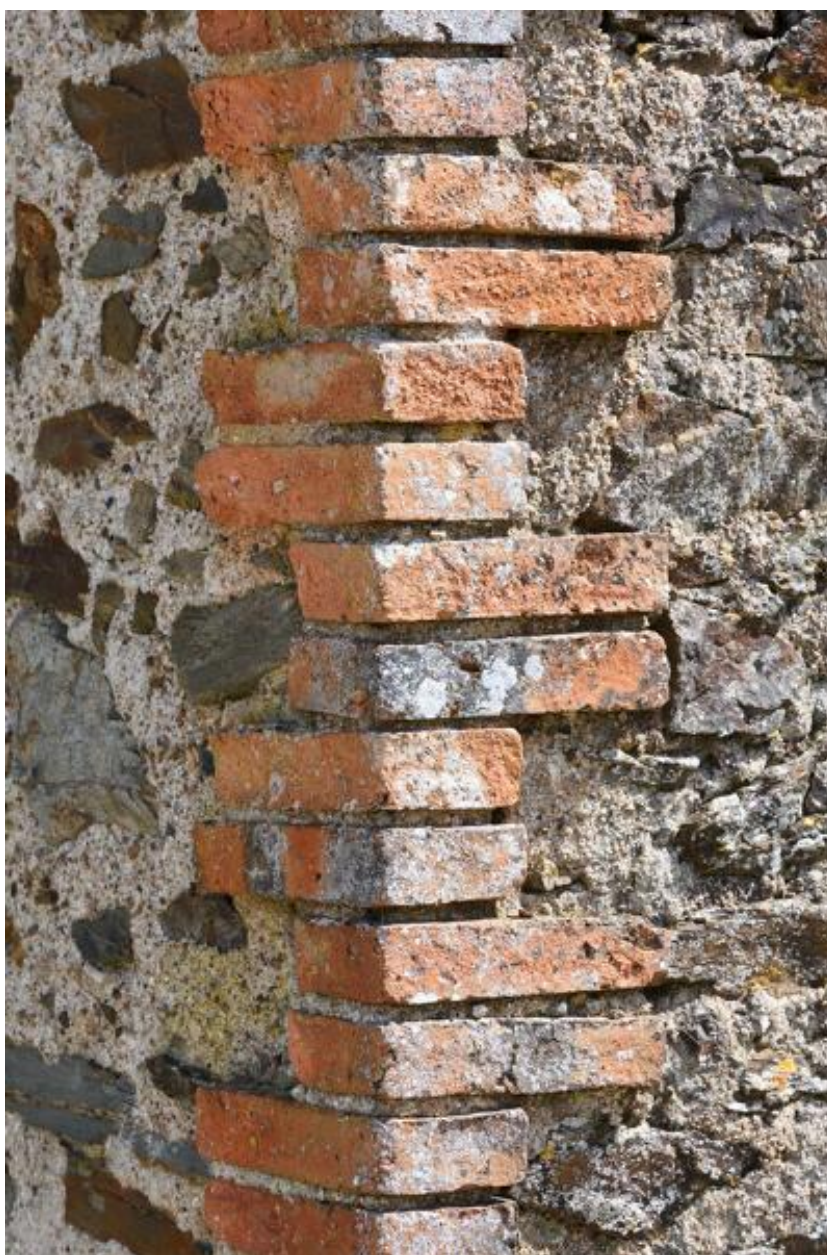
Façade ouest. Détail d'un chaîne d'angle en brique.
