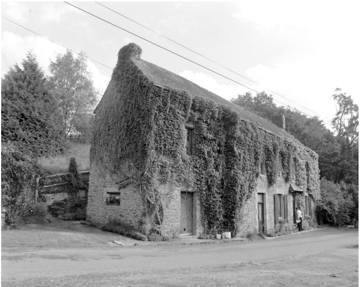
L'ancienne maison de meunier : façade antérieure et pignon nord.
