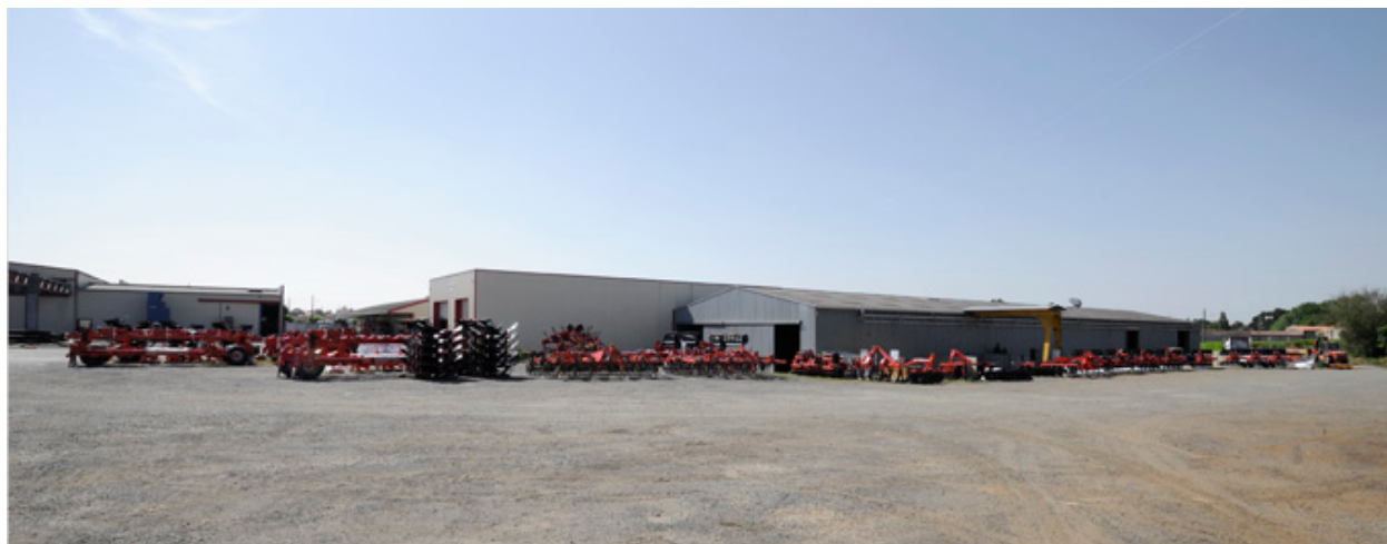
Usine Grégoire-Besson : vue depuis le nord.
