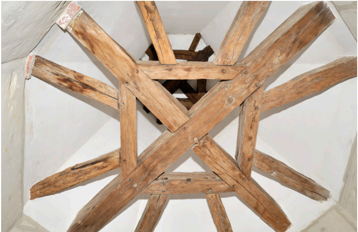
Tourelle d'escalier : enrayure basse de la charpente.
