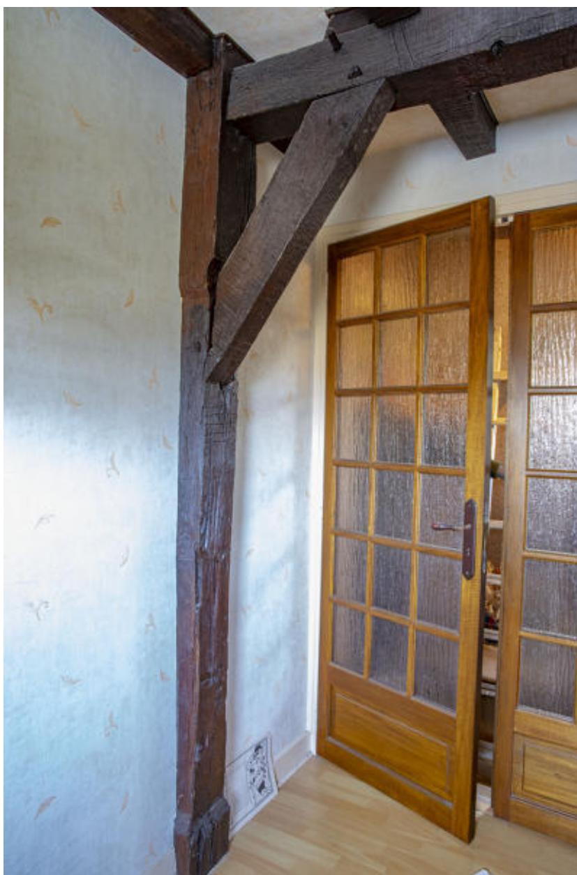
Vue de la partie inférieure du poinçon et de l'aiselier sud de la charpente.
