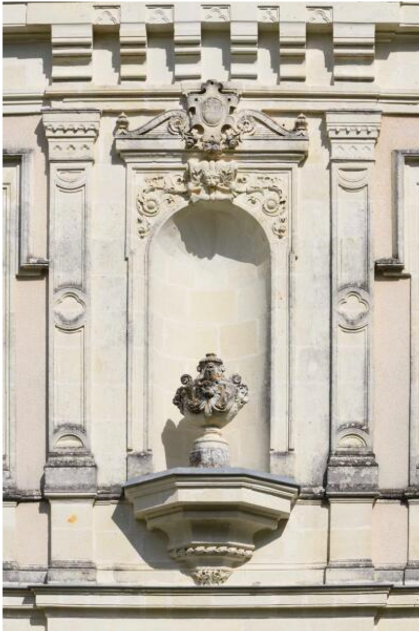
Détail d'une niche concave ornée, façade ouest du château de la Barre.
