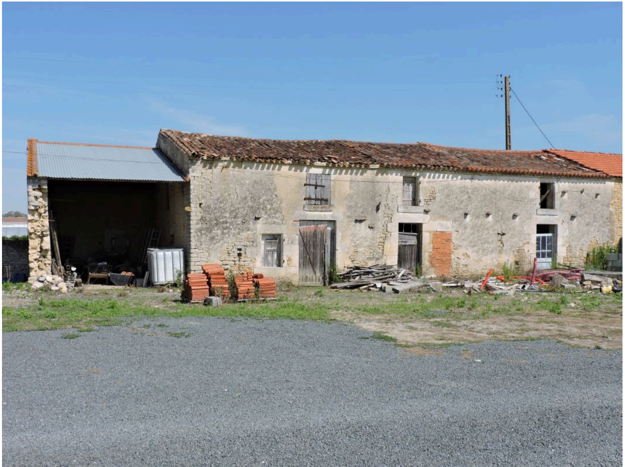
La maison vue depuis le sud-est.
