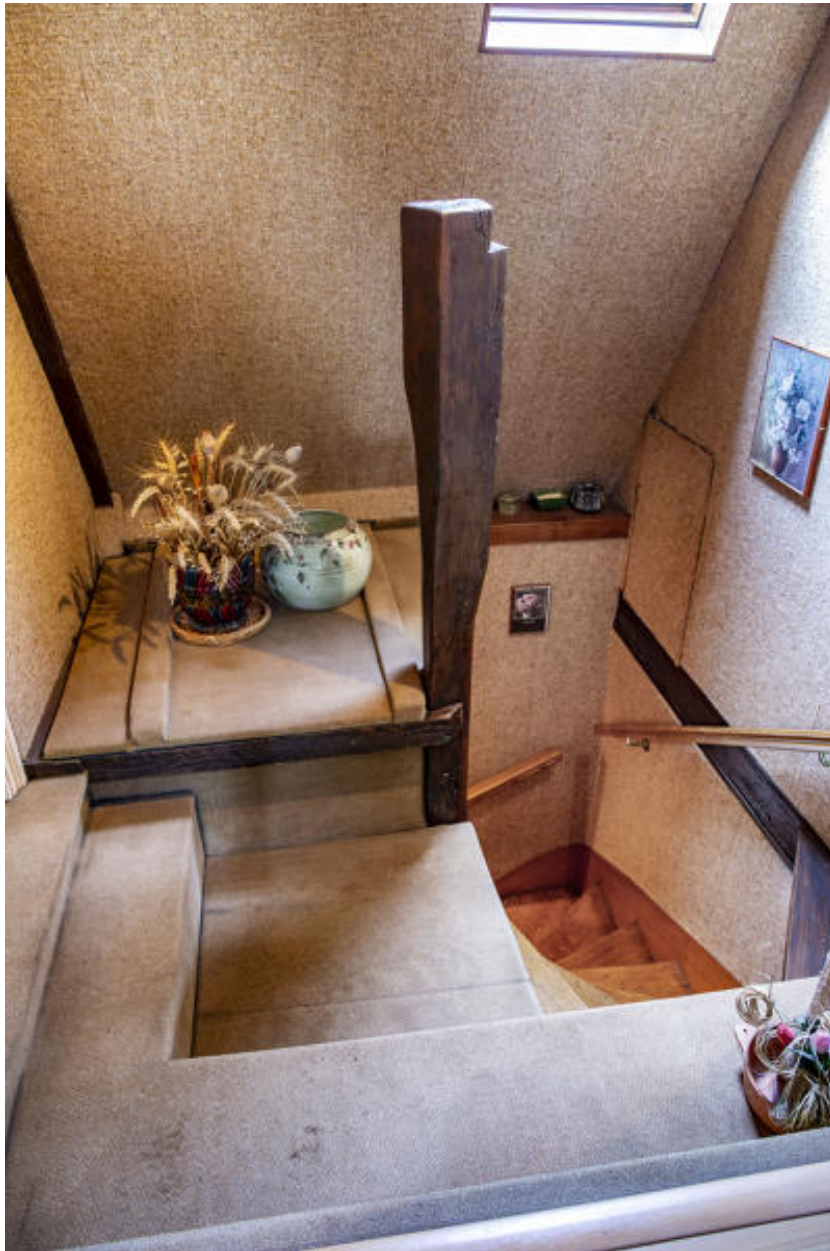
Vue du noyau de l'escalier à vis.
