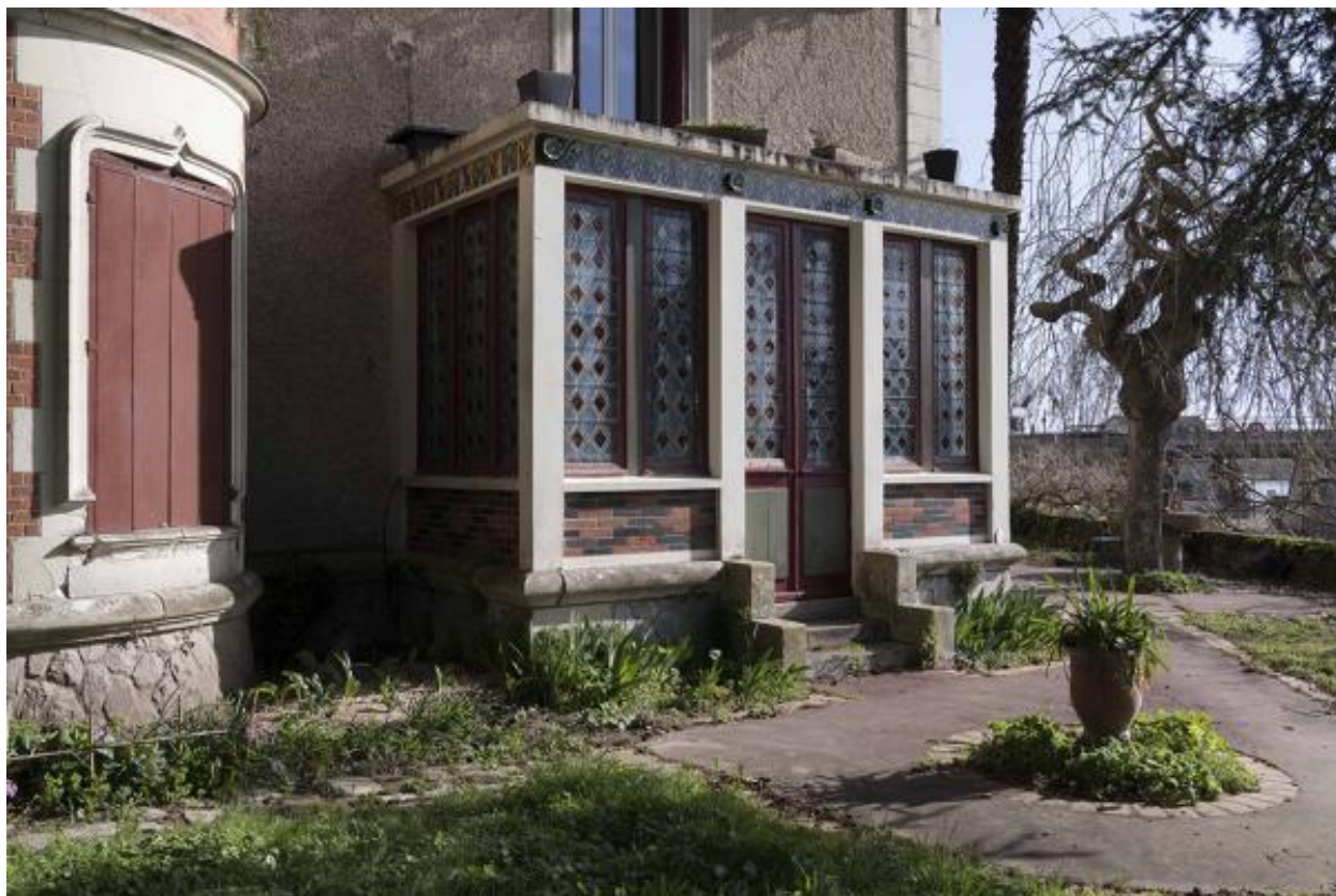
Vue de la véranda depuis le sud-ouest.
