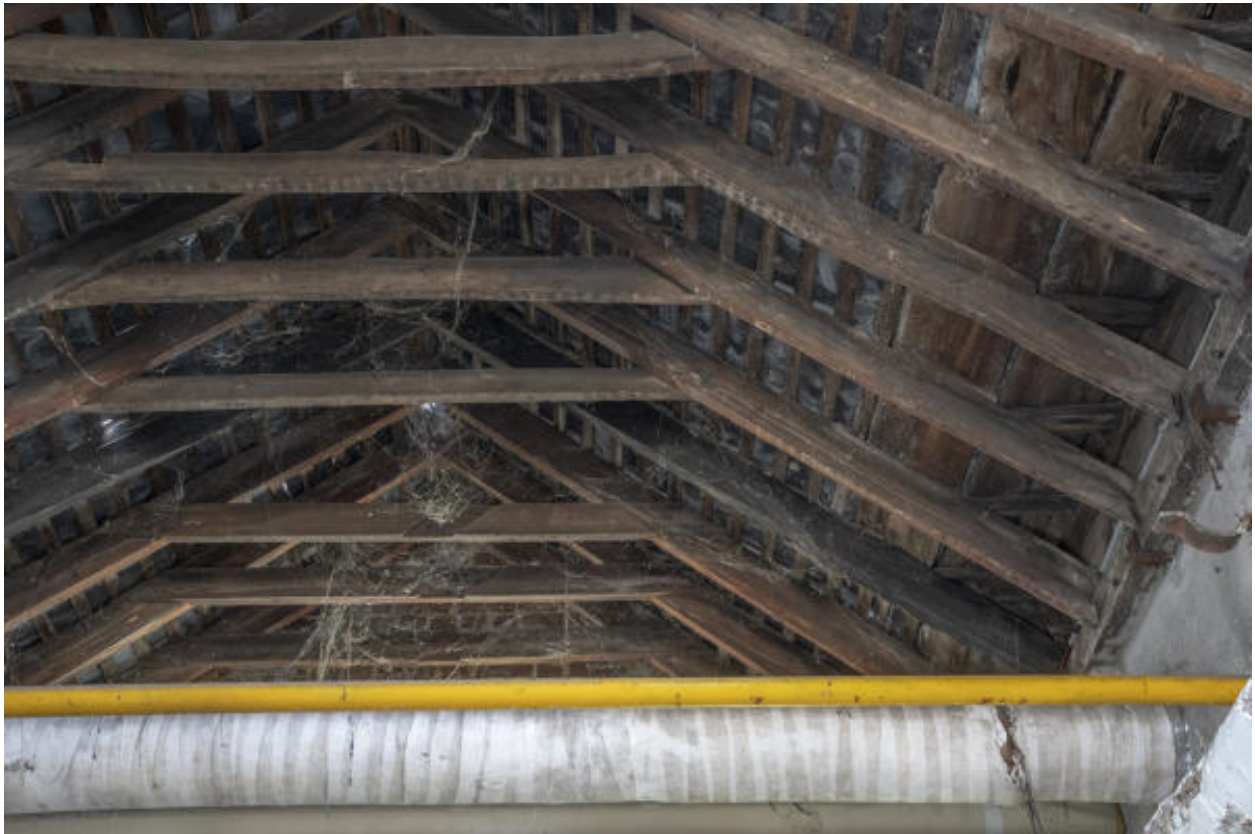
Vue de la charpente en planches de l'atelier E.
