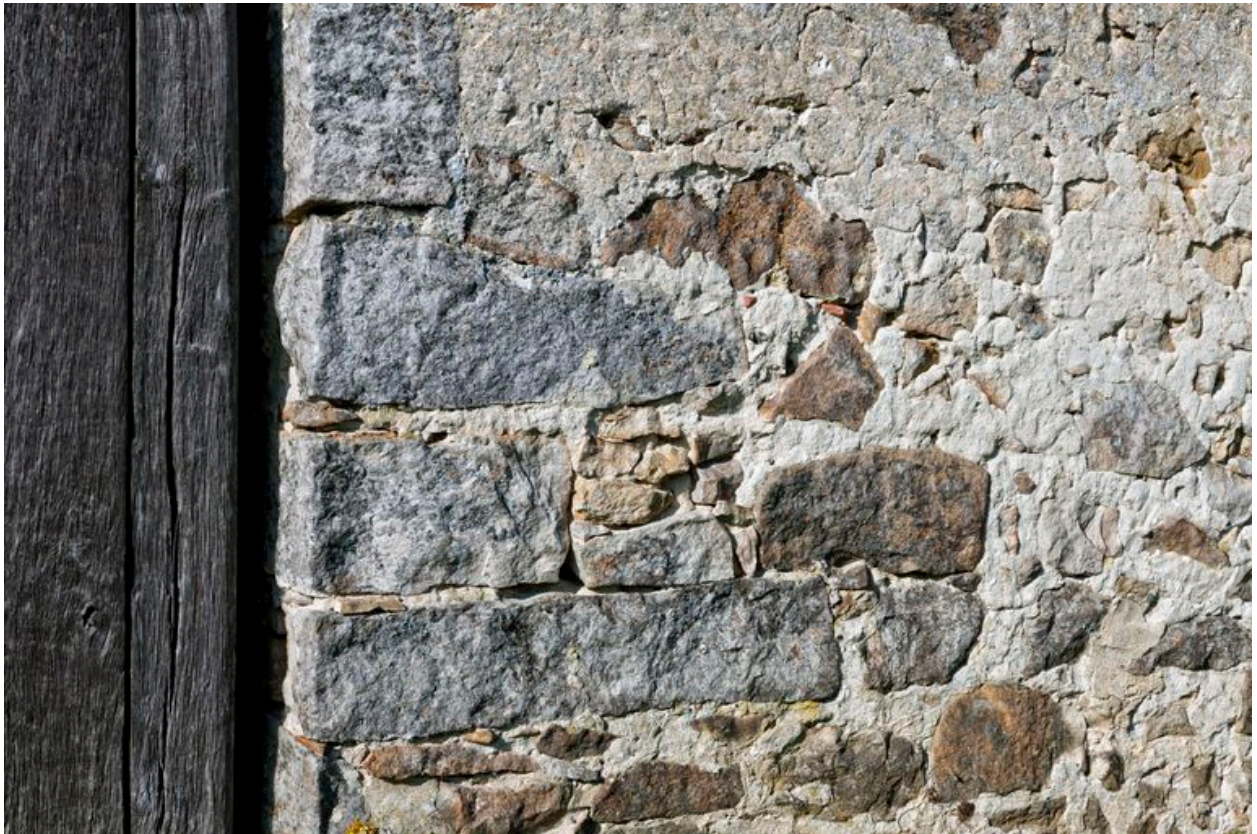
Détail du piédroit droit de la porte de la grange.
