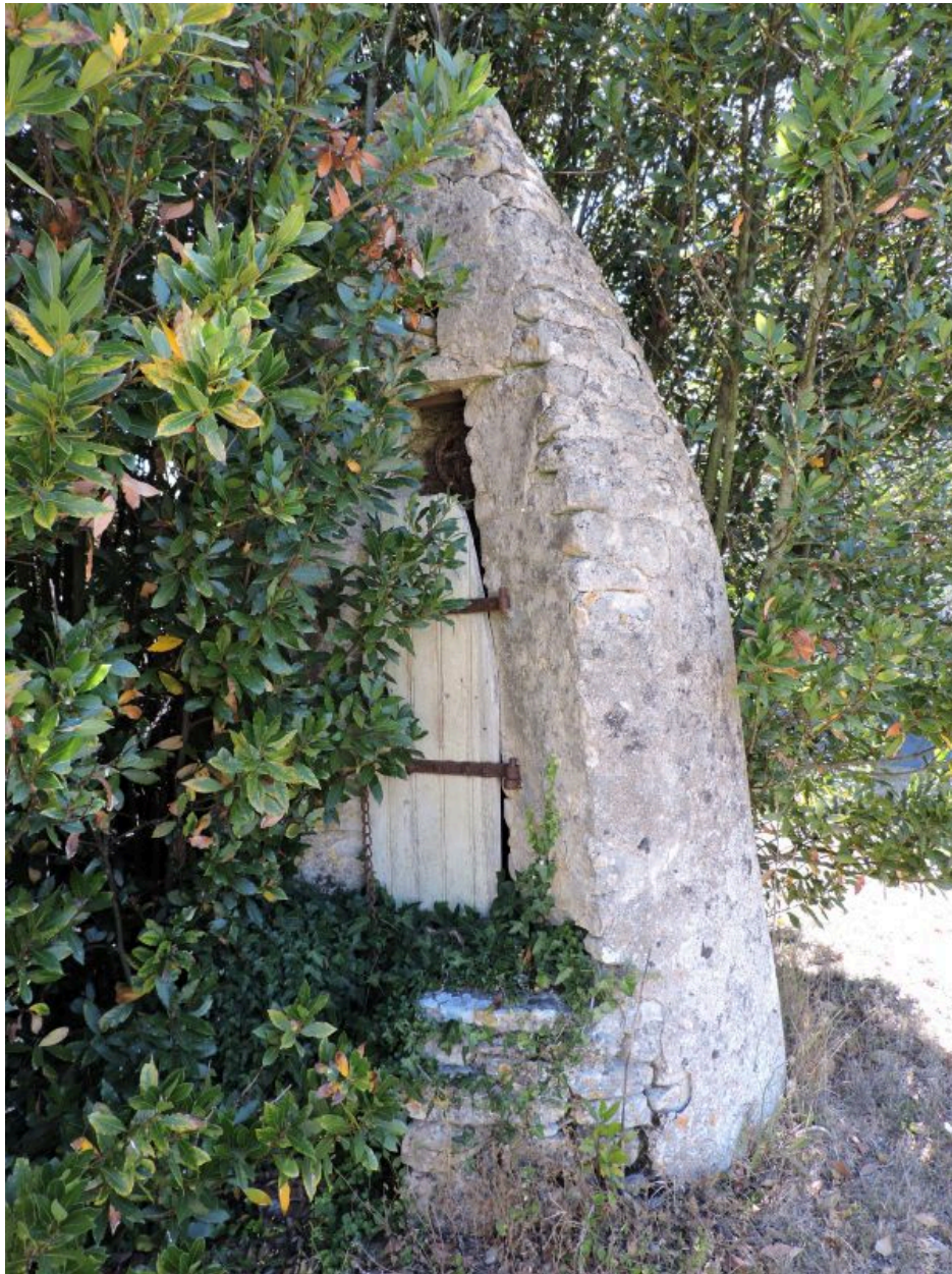
Le puits couvert, au nord de la cour, vu depuis l'ouest.
