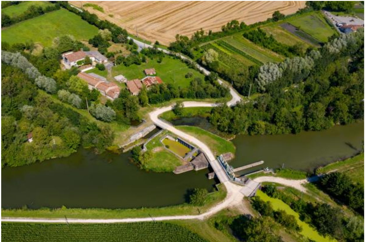
Vue aérienne de l'aqueduc depuis le sud.
