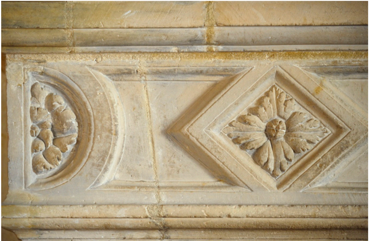
Cheminée monumentale : détail des ornements en losanges et demi-cercles fleuronnés.
