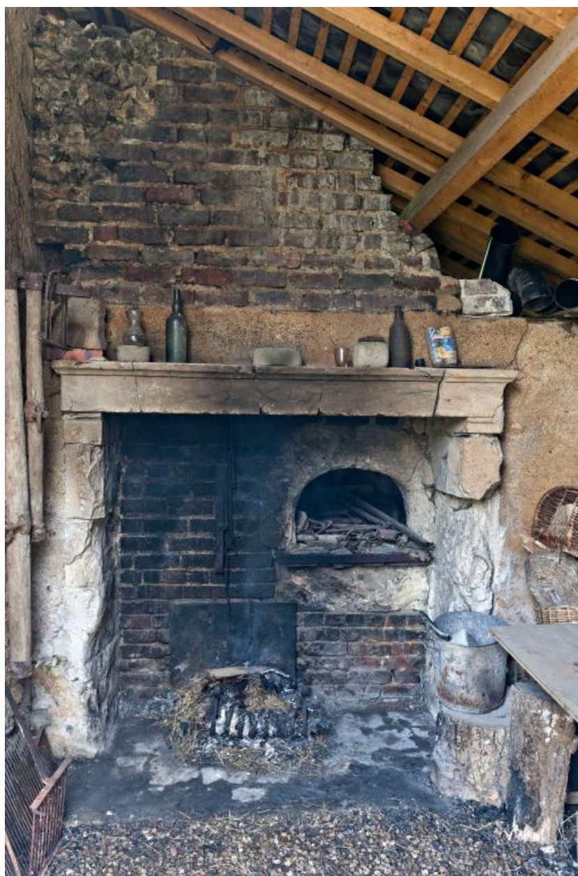
Dépendance agricole : cheminée dotée d'un four à pain.
