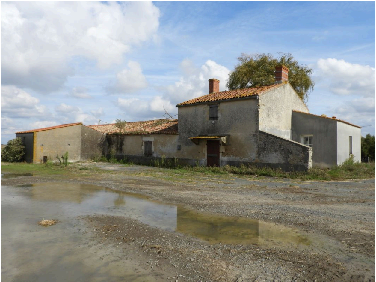
Le logis vu depuis l'ouest.
