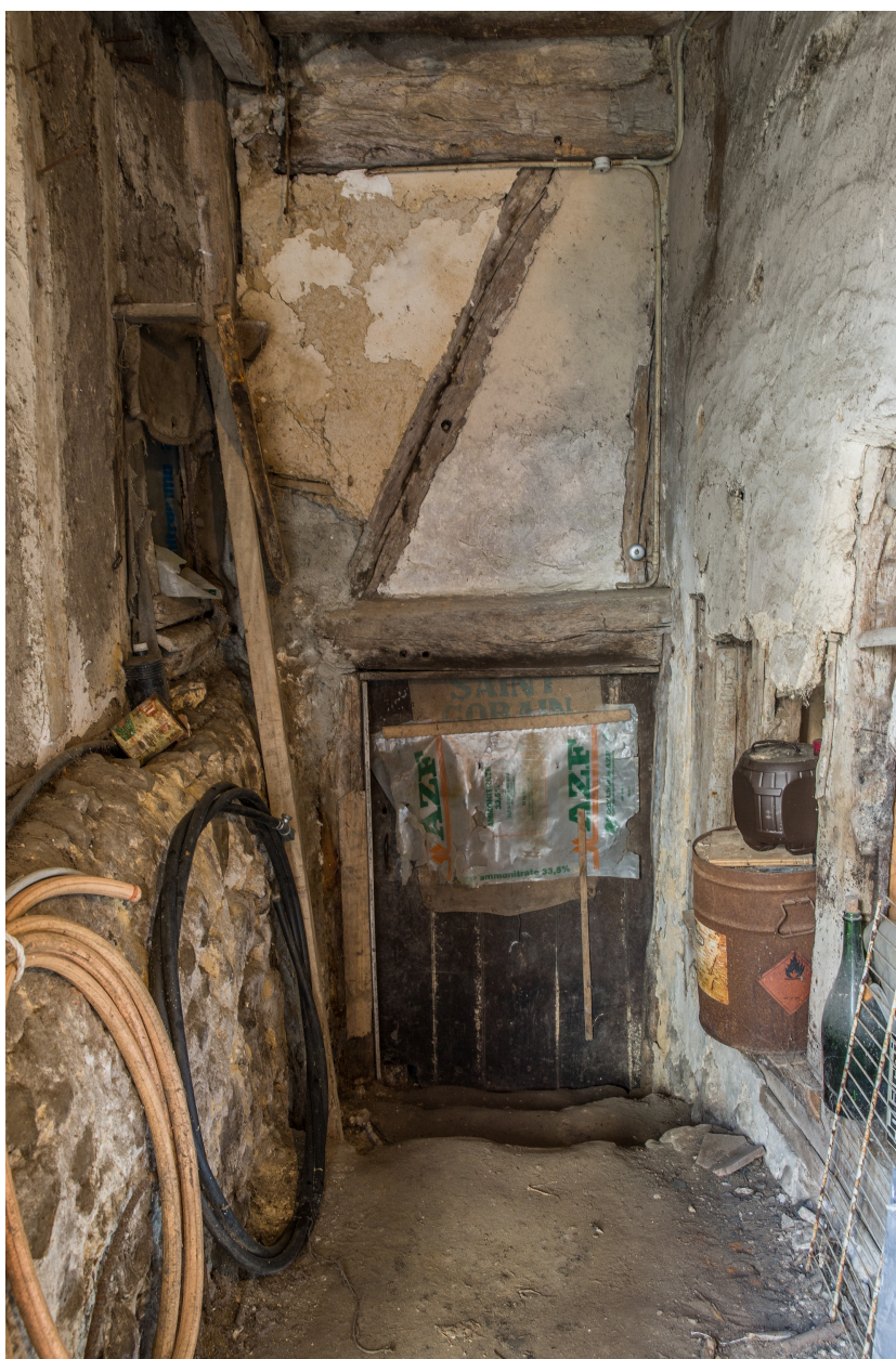
L'accès à la cave du logement à pièce unique.
