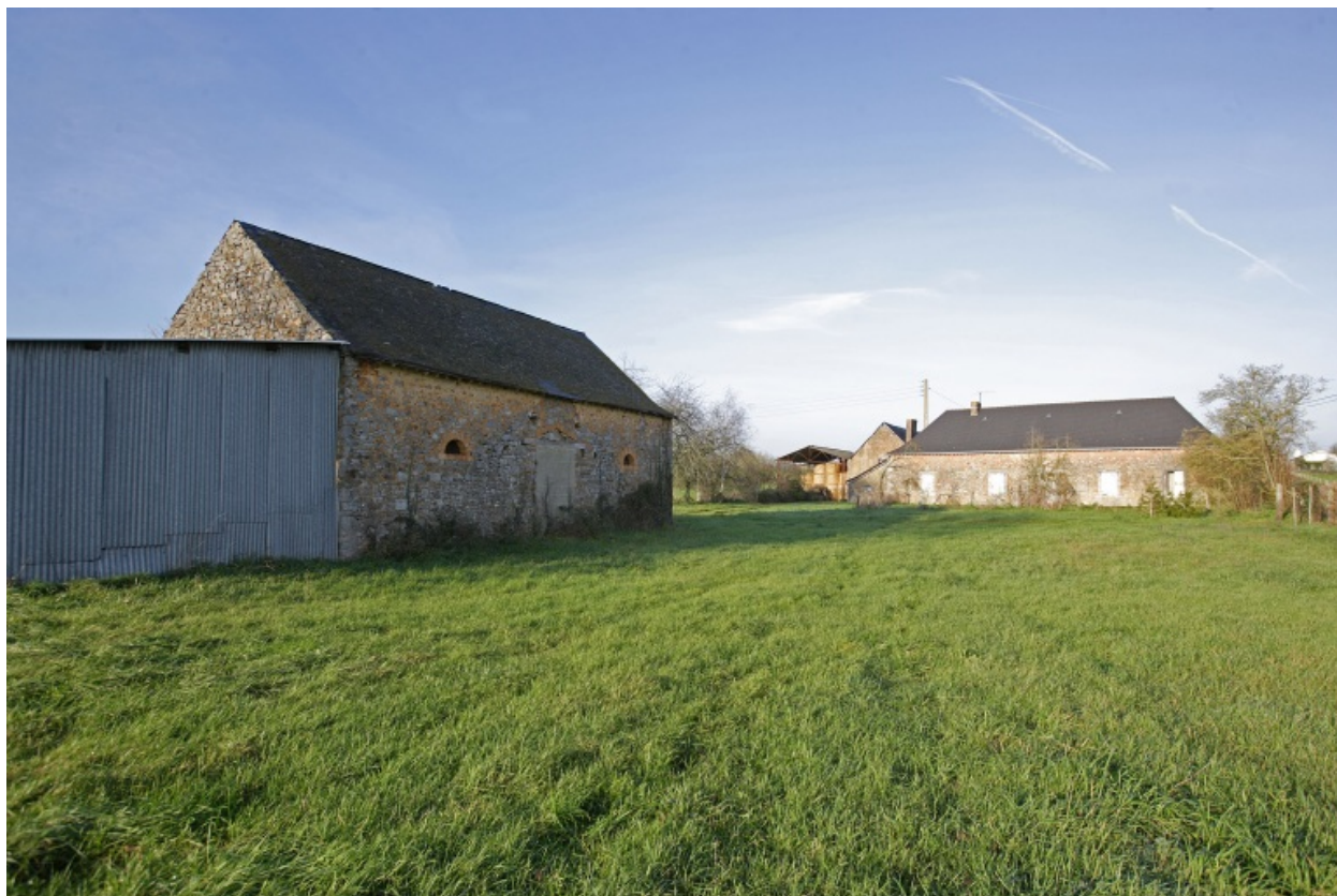
La remise et le logis vus depuis le sud.
