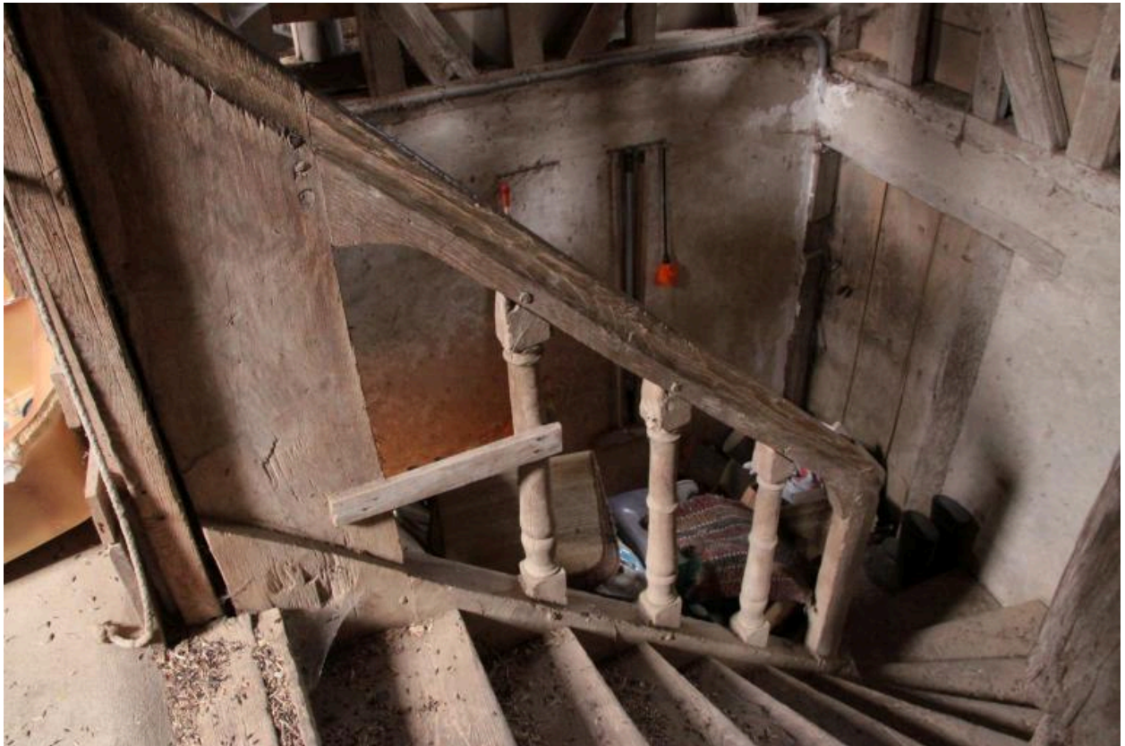
Maison : escalier menant au comble.
