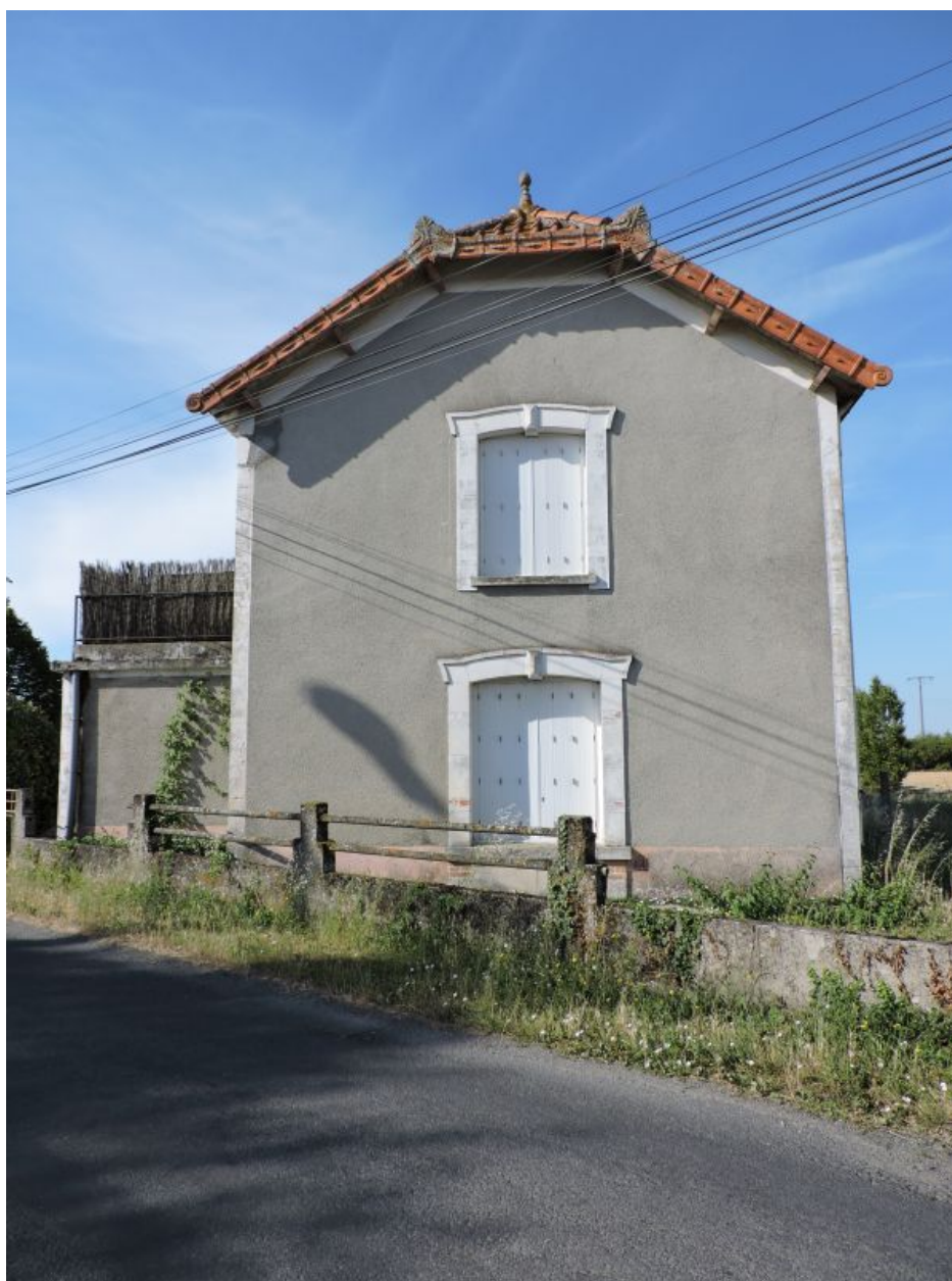
Le mur pignon nord du logis.
