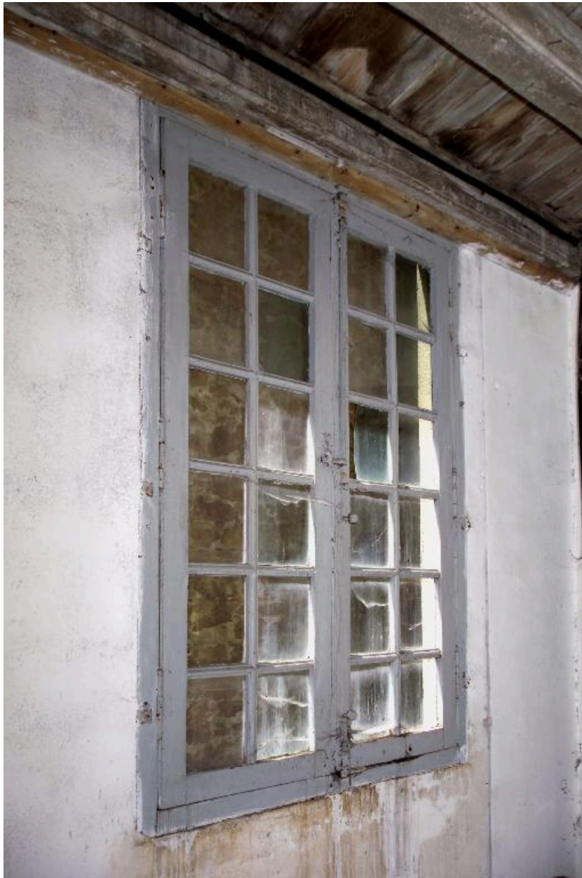
L'escalier, la baie du premier étage.
