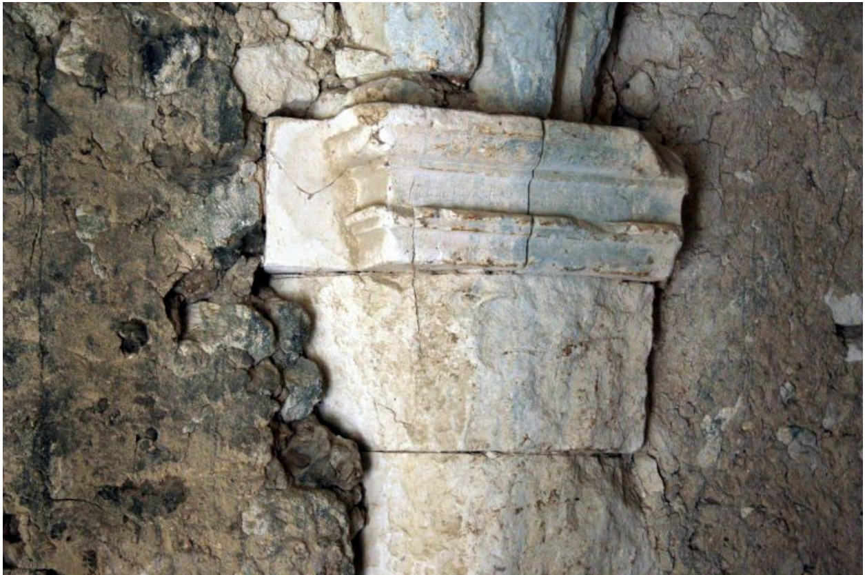
Ancien château, rez-de-chaussée, 2e salle voûtée d'ogives : culot mouluré.
