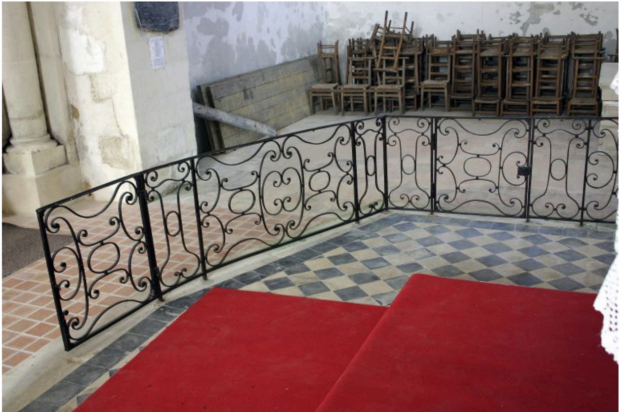
Clôture de chœur, côté nord.
