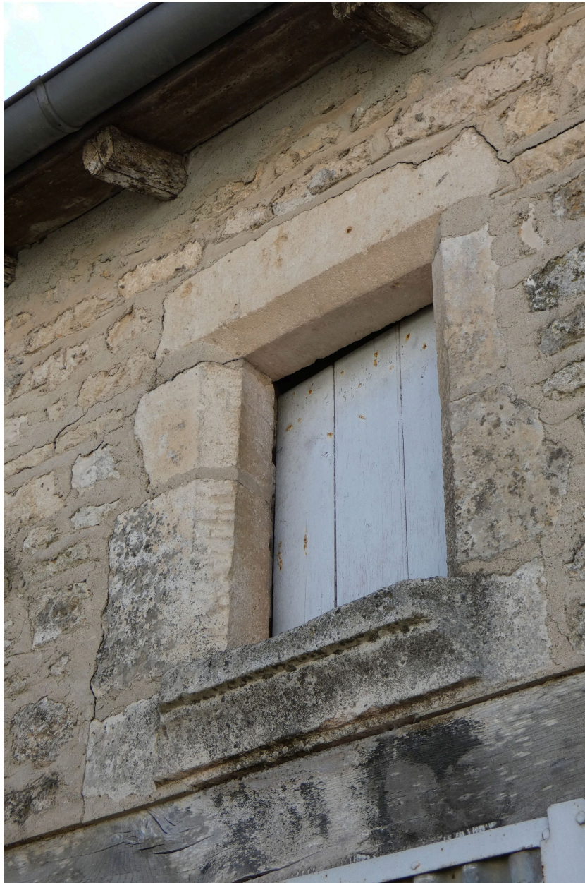
Baie à encadrement chanfreiné et appui mouluré.
