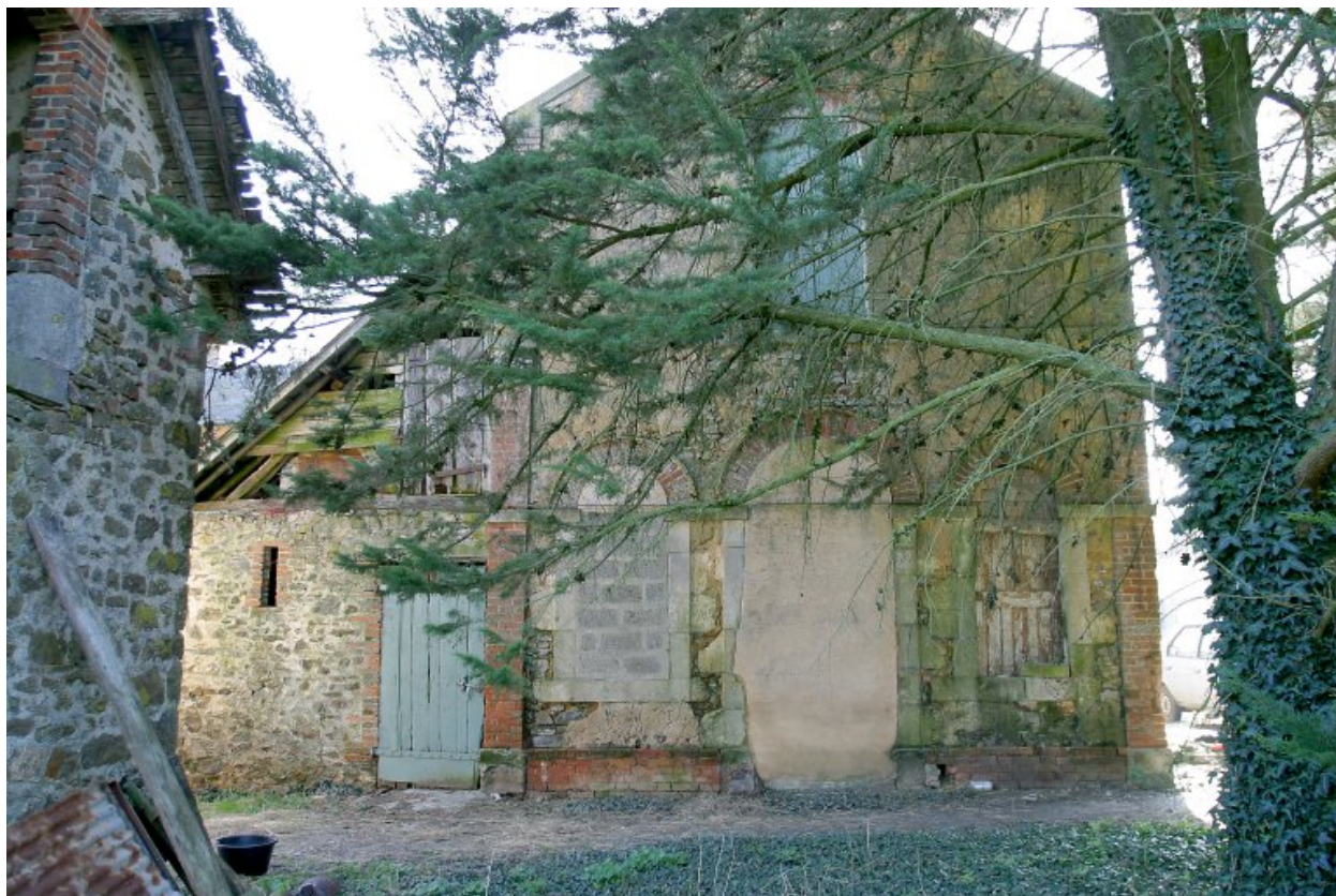
Le logis-écurie : pignon ouest de l'écurie.
