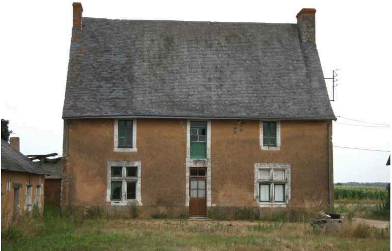
Façade antérieure sur cour.
