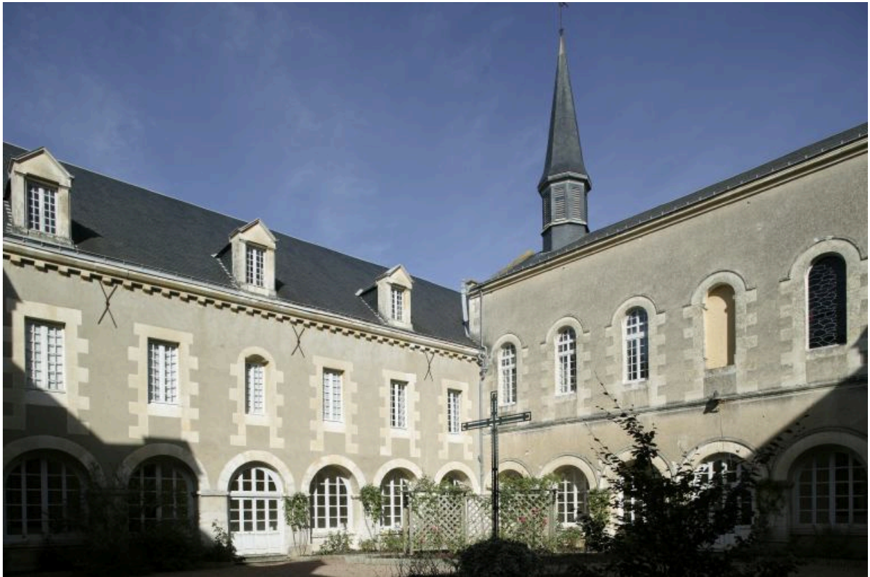
Vue des bâtiments conventuels, prise du sud-est du préau.
