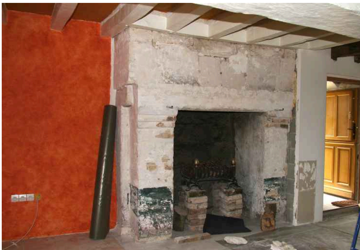
Pignon gauche : cheminée remaniée.
