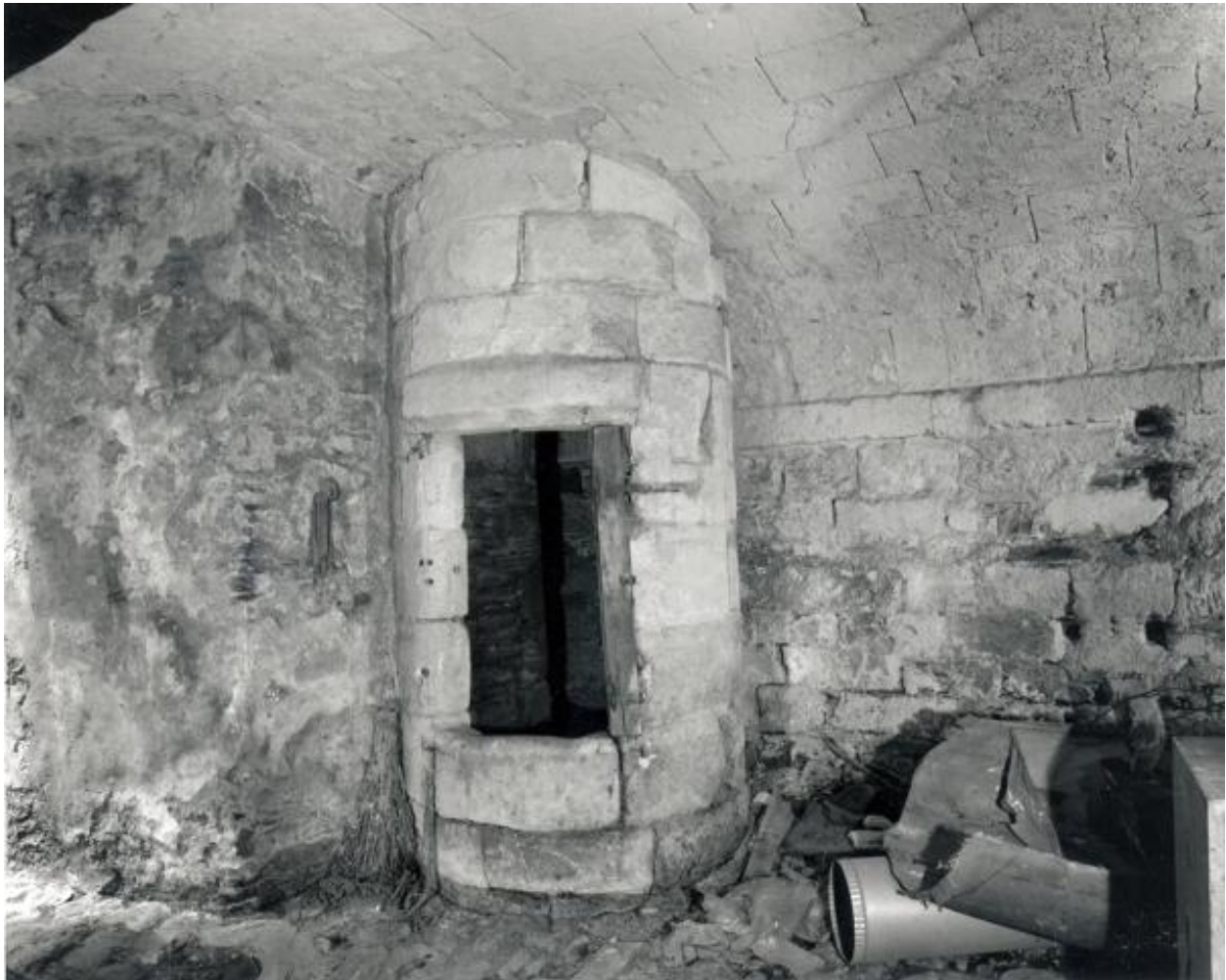
Aile nord du cloître, extrémité est, sous-sol, cave centrale, mur sud : le puits, vue d'ensemble.
