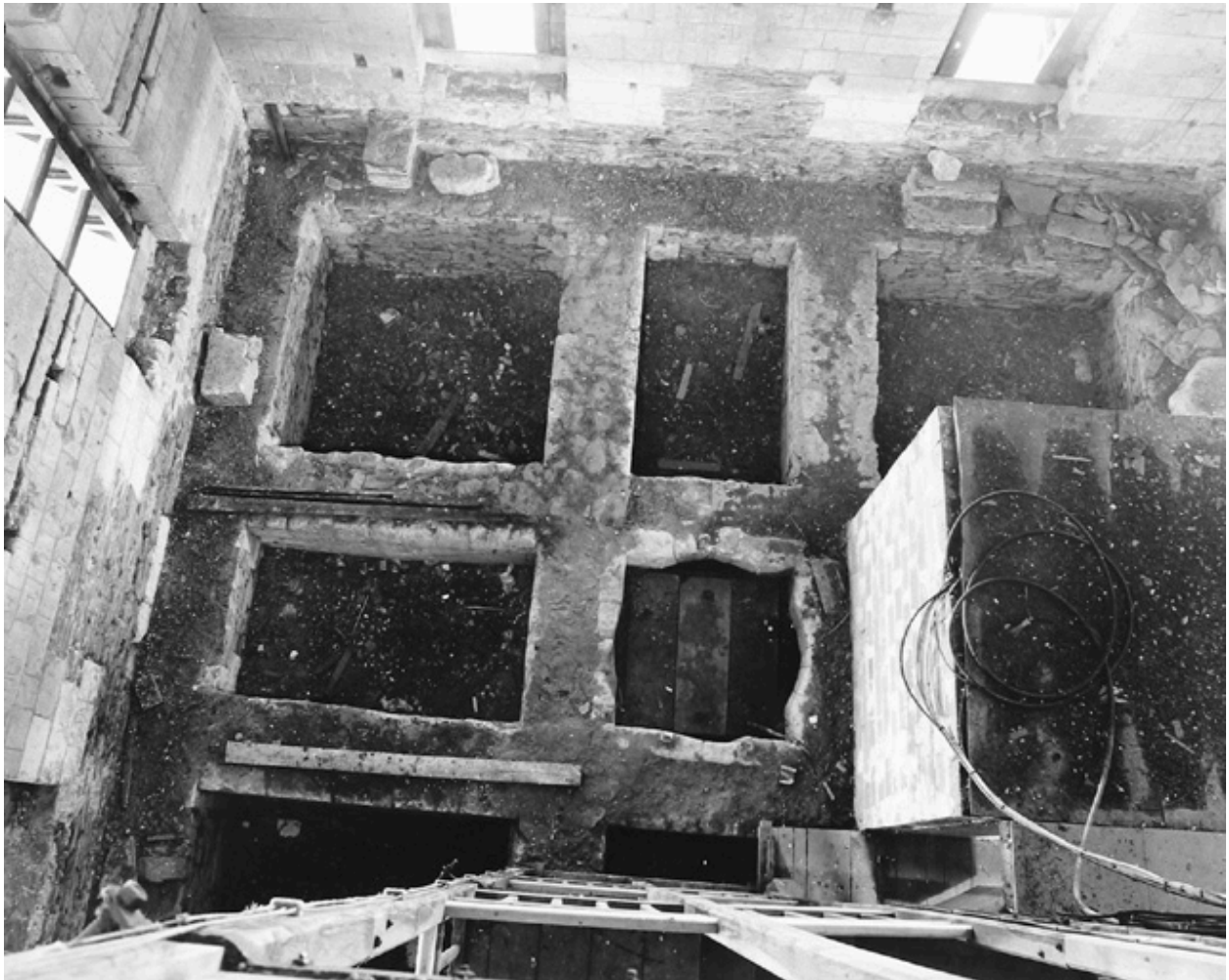
Tour-clocher dite tour Saint-Aubin, chambre des cloches, vue partielle de la structure au sol destiné à supporter le beffroi.
