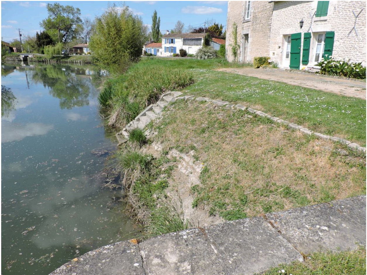
Vestiges de perré maçonneré en aval de l'écluse, rive droite.
