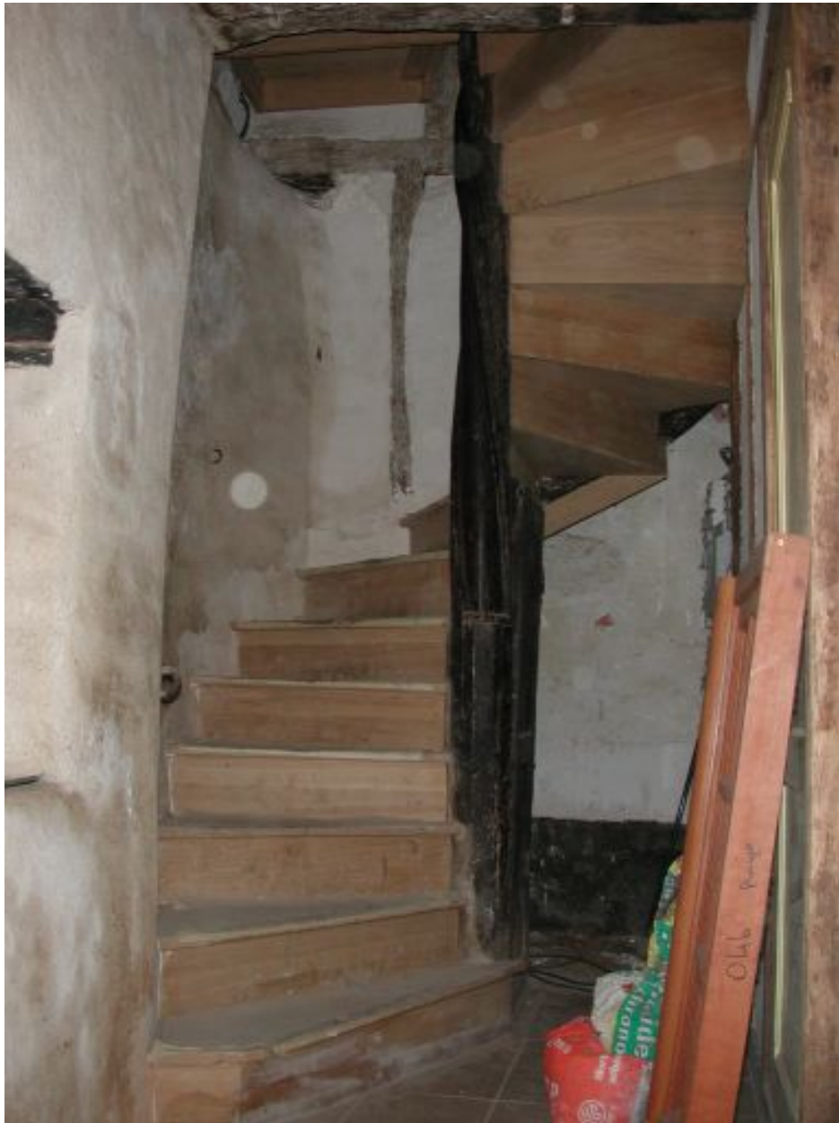
Cage d'escalier, vue depuis l'entrée du couloir, pendant les travaux d'octobre 2002.
