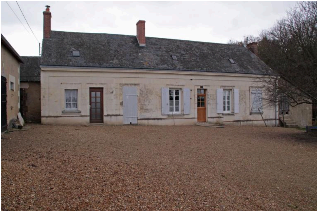
Maison, façade antérieure sur cour.
