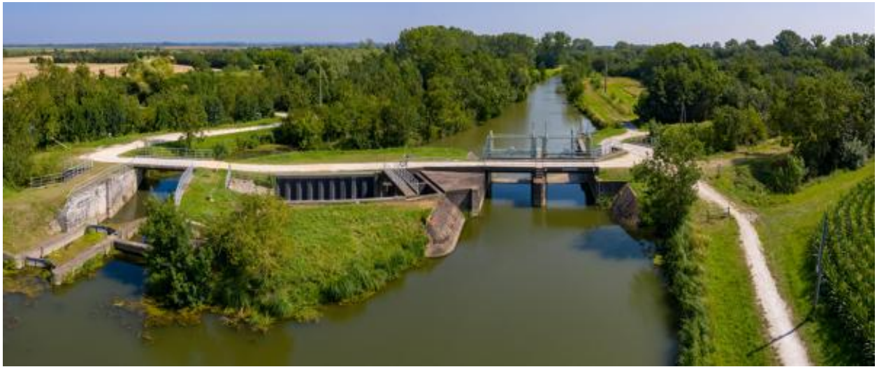
Vue aérienne de l'aqueduc depuis le sud.
