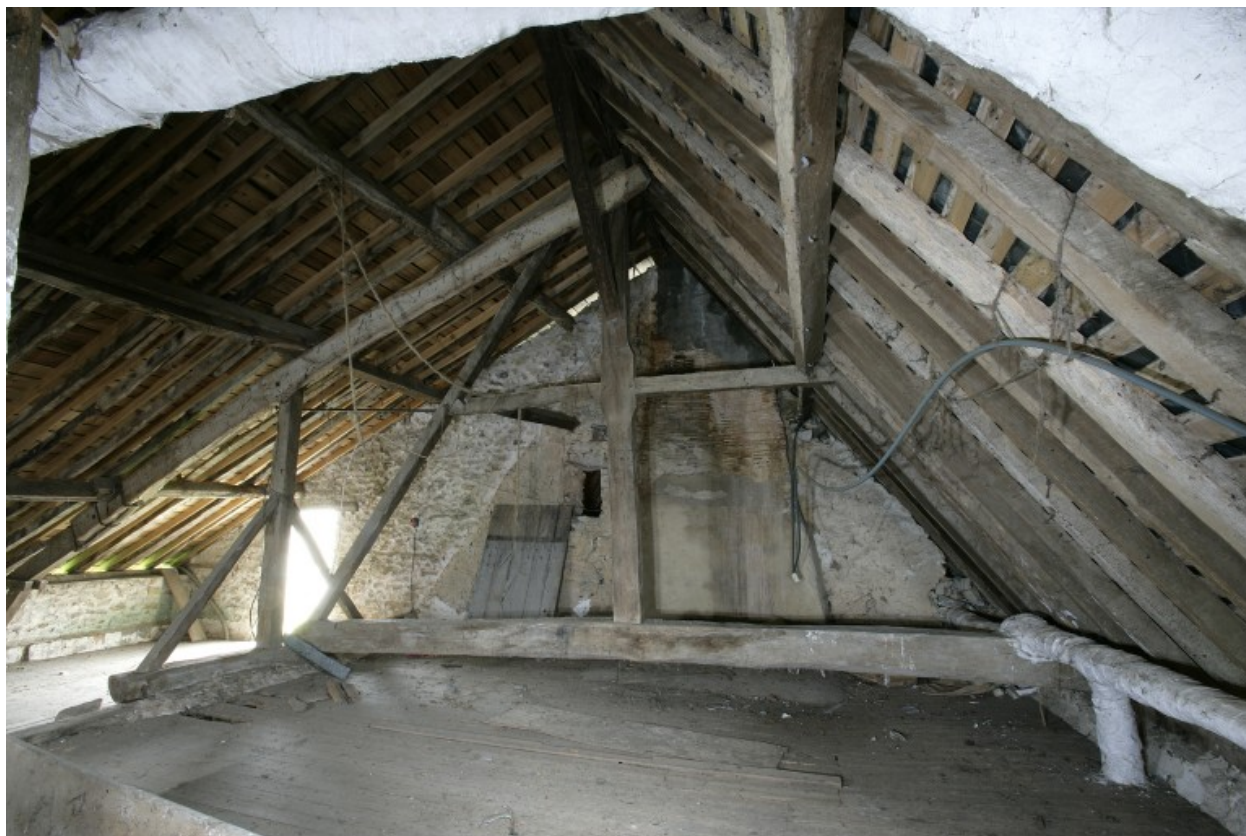
La charpente du logis vue depuis le nord-ouest.
