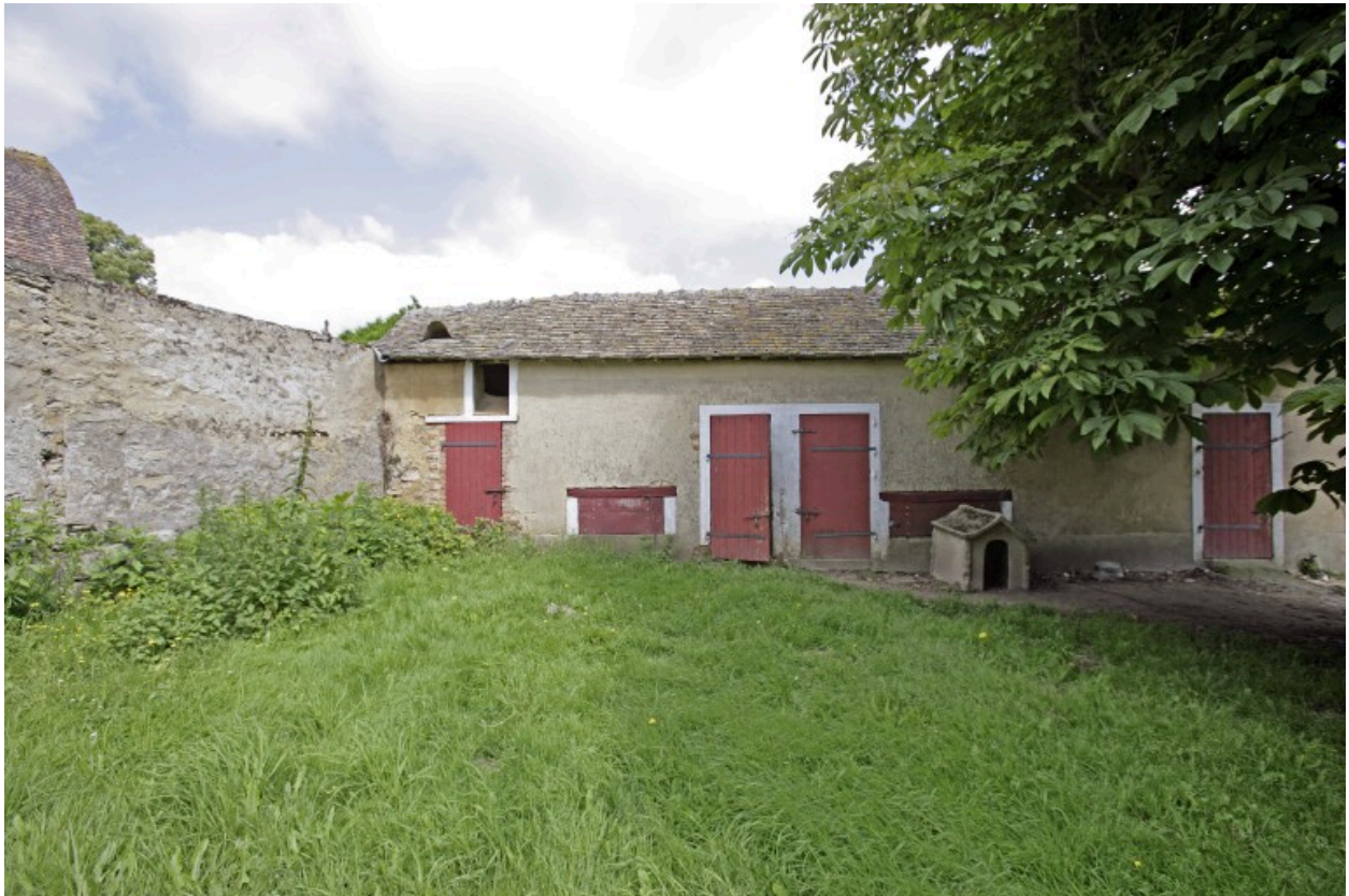
Porcheries, élévation sur cour.
