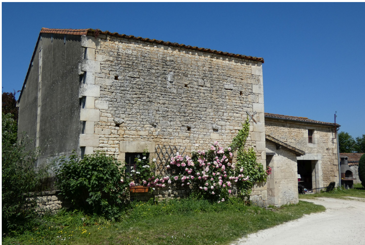
Les dépendances à l'ouest de la cour, vues depuis le sud.
