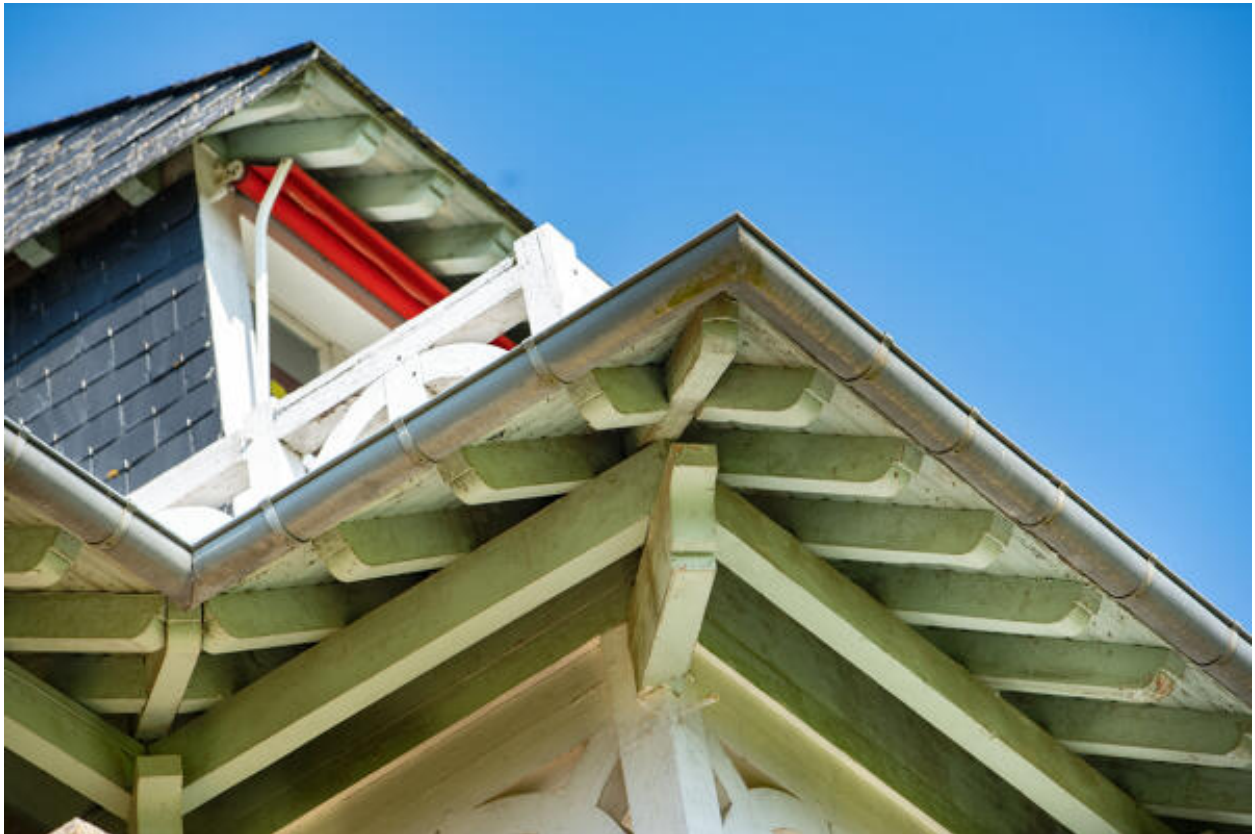
Un détail des débords de toit.
