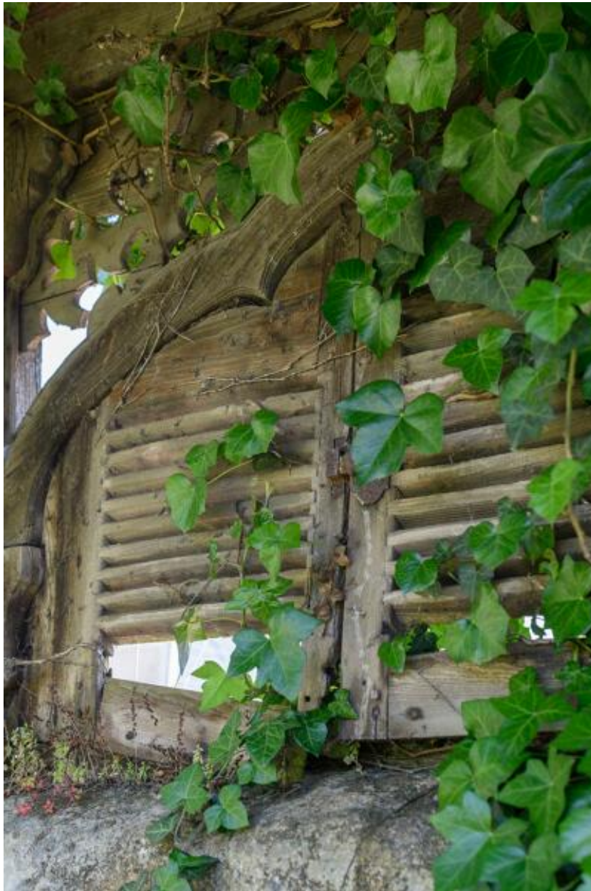
Pavillon de jardin. Détail des volets en bois.
